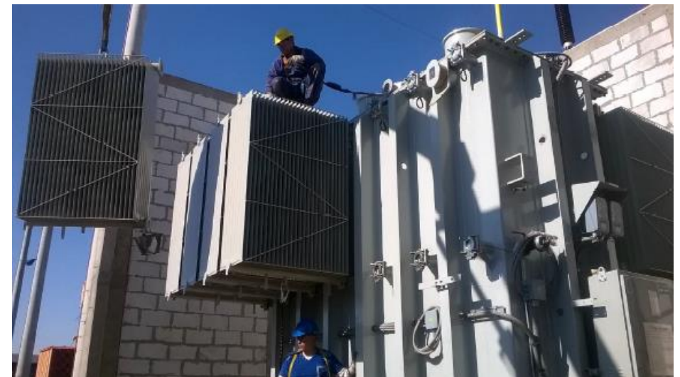
31/08/16 – Instalación de transformadores de 68 MVA
