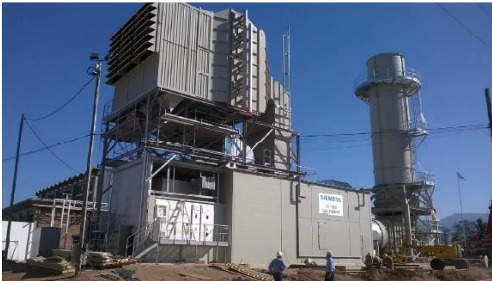
31/08/16 – Nueva turbina Siemens SGT-800 instalada en CT
